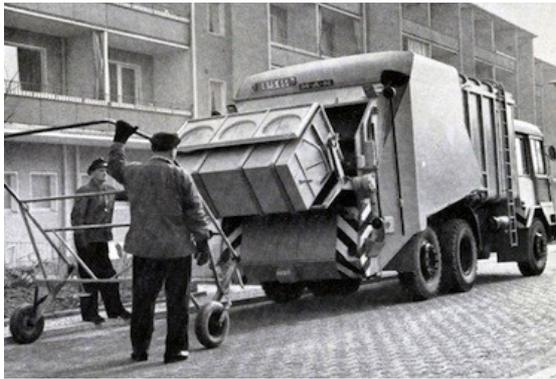
*Beladen eines MAN mit Hilfe eines Sulkys*
